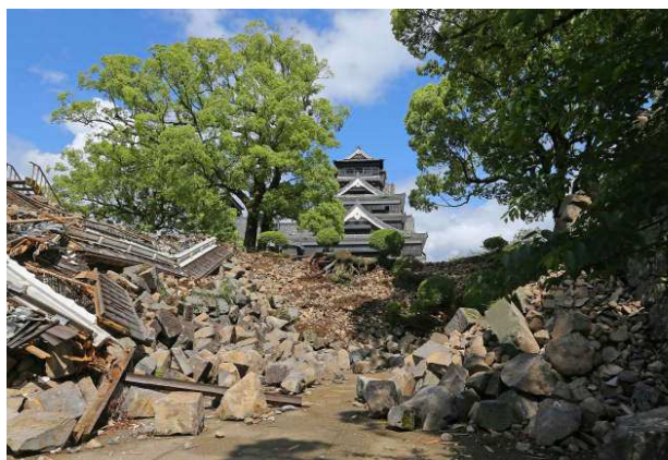
【熊本城の被災状況】
